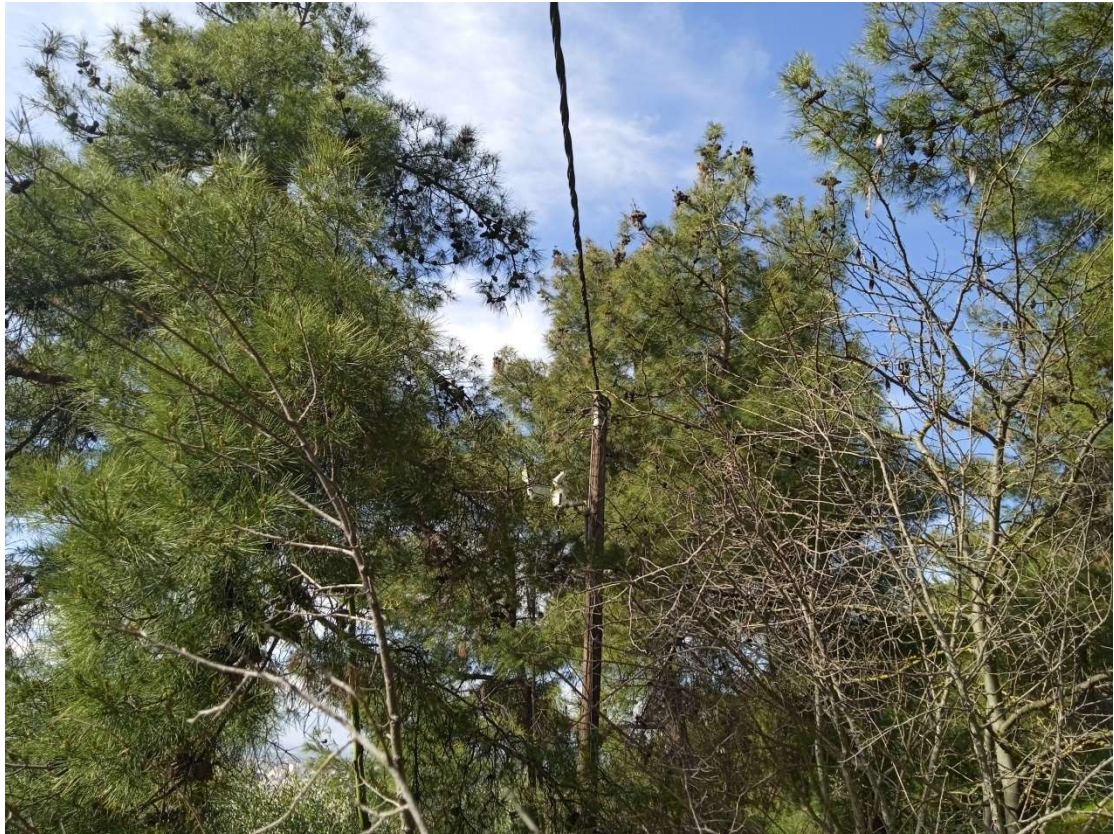
Φωτογραφίες 5,6 : Κλαδιά ατόμων πεύκης σε επαφή με ηλεκτροφόρα καλώδια
