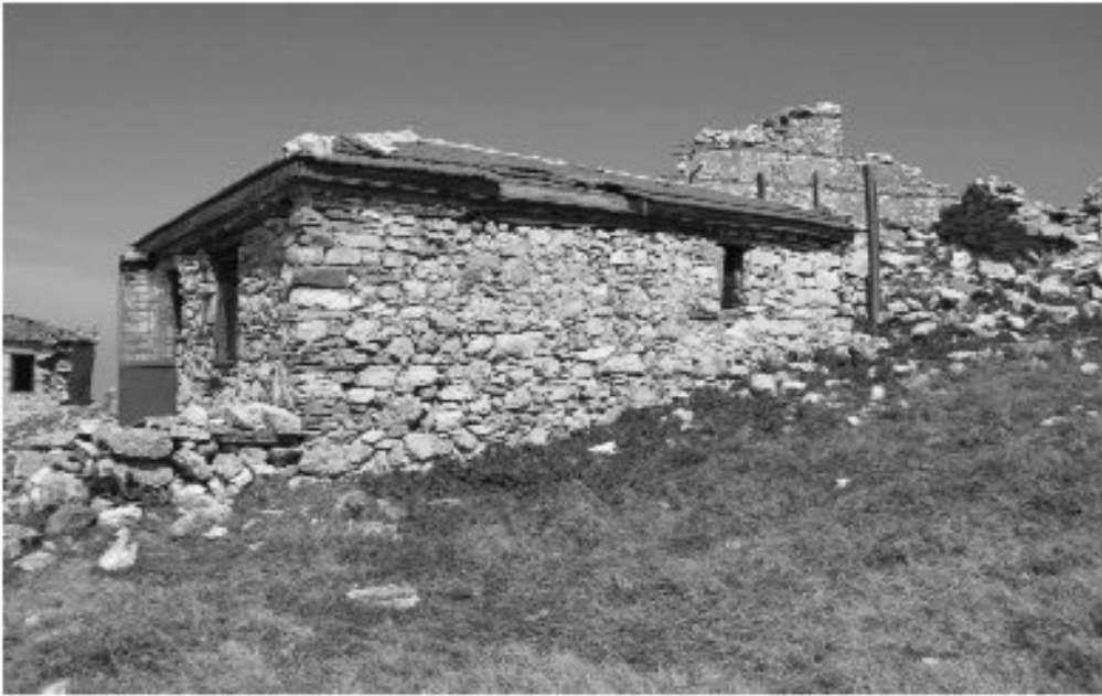
Εικ. 1. Μεσολακκιά. Ναϊβδριο Αγίων Θεοδώρων. Άποψη από ΝΔ.
