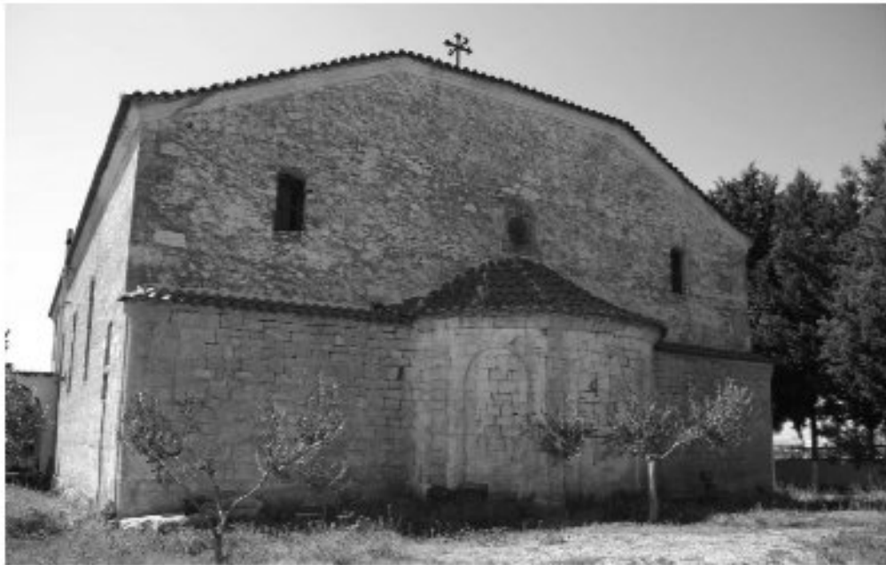
Εικ. 4 Παλαιοκόμη Ναός Κοίμησης Θεοτόκου. Η ανατολική πλευρά. Η αψίδα και ο τοίχος ως το σημείο που διαμορφώνεται η προεξοχή με τα κεραμίδια ανήκει στην πρώτη φάση του ναού (18 ος αι.).
