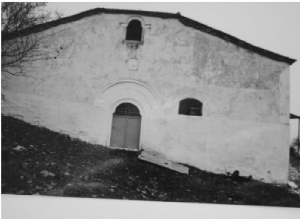
Εικ. 14. Άνω Πορόια. Ναός Αγίου Γεωργίου. Δυτική πλευρά.
