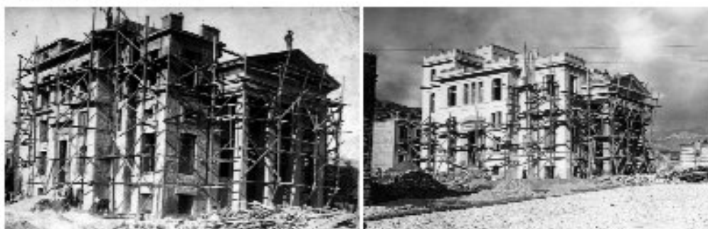
Εικ. 12. Απόψεις του κτιρίου κατά τη φάση ανέγερσης (Ι.Α./Ε.Τ.Ε).
