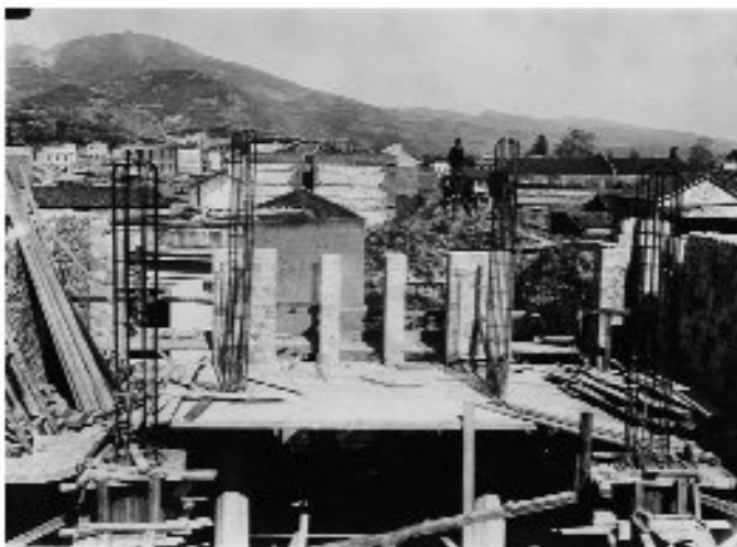
Εικ. 8. Σκυροδέτηση του υποκαταστήματος Σερρών (αρχείο Ι. Ισηγόνη, Ι.Α./Ε.Τ.Ε).
