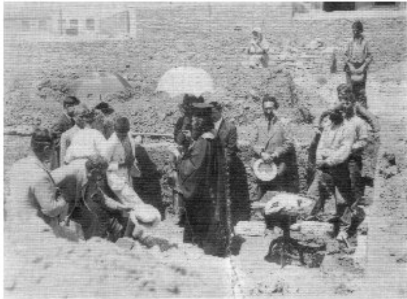
Εικ. 7: Η θεμελίωση του υποκαταστήματος (Τζανακάρη, 1995: 165).
