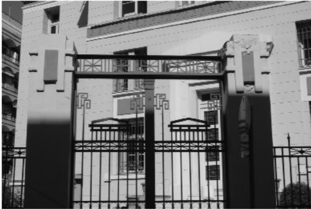
Εικ. 23. Η περίφραξη από δυτικά με το χαρακτηριστικό κυκλίδομα. Διακρίνεται η πρόωγη είσοδος στην κατοικία του διευθυντή.
