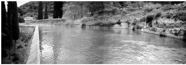
Εικ. 16. Άποψη δεξαμενής φορτίσεως.
