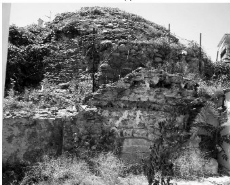
β. άποψη από οδό Χατζηπανταζή (φωτ. 2001).
