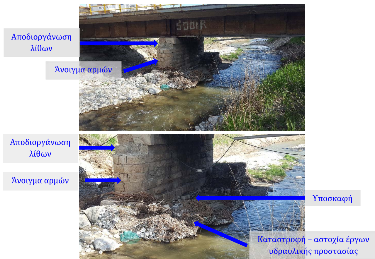
Σχήμα 4.11: Φωτογραφίες μεσαίου μεσόβαθρου M2, δυτική πλευρά (αυτοψία 14-4-2021).
