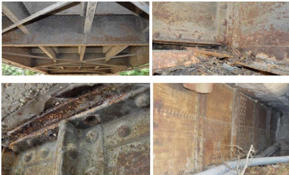
Σχήμα 4.5: Φωτογραφίες μεταλλικής εσχάρας δοκών (αυτοψία μετά από πλημμύρα 21-6-2020).
