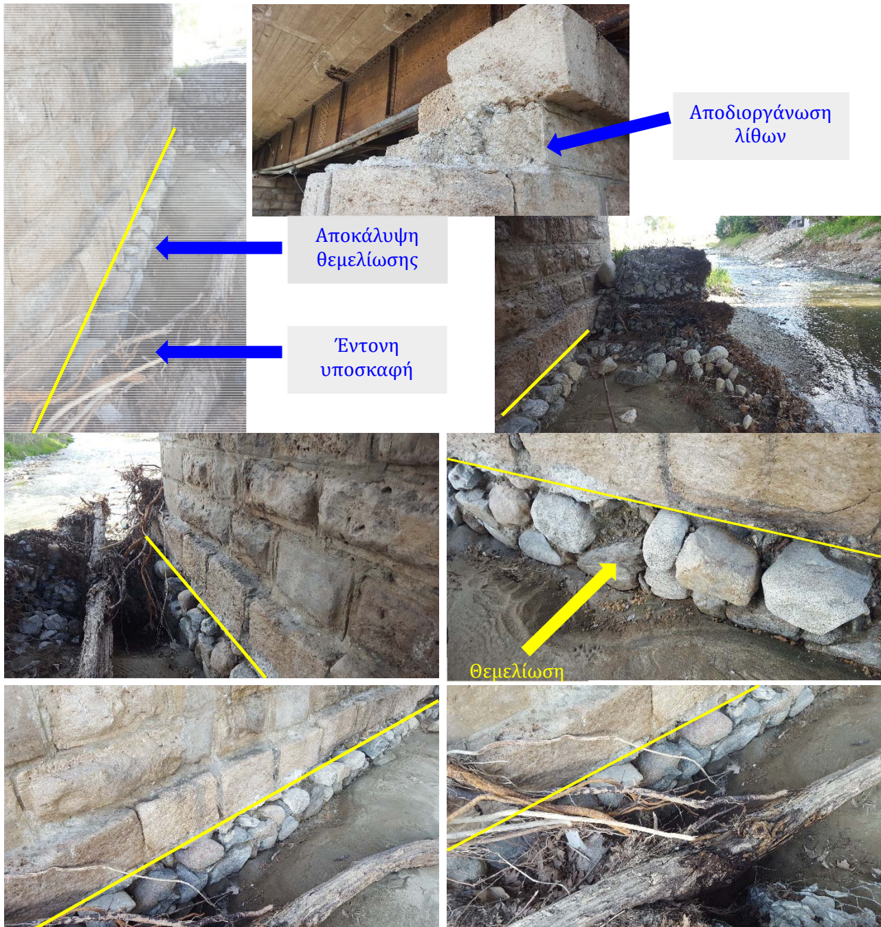
Σχήμα 4.12: Φωτογραφίες μεσαίου μεσόβαθρου M2, δυτική πλευρά (αυτοψία 14-4-2021).
