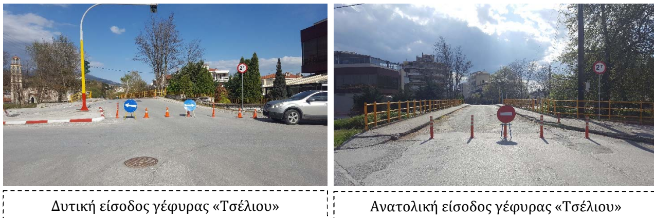
Σχήμα 4.10: Φωτογραφίες κλειστής γέφυρας (αυτοψία 14-4-2021).
