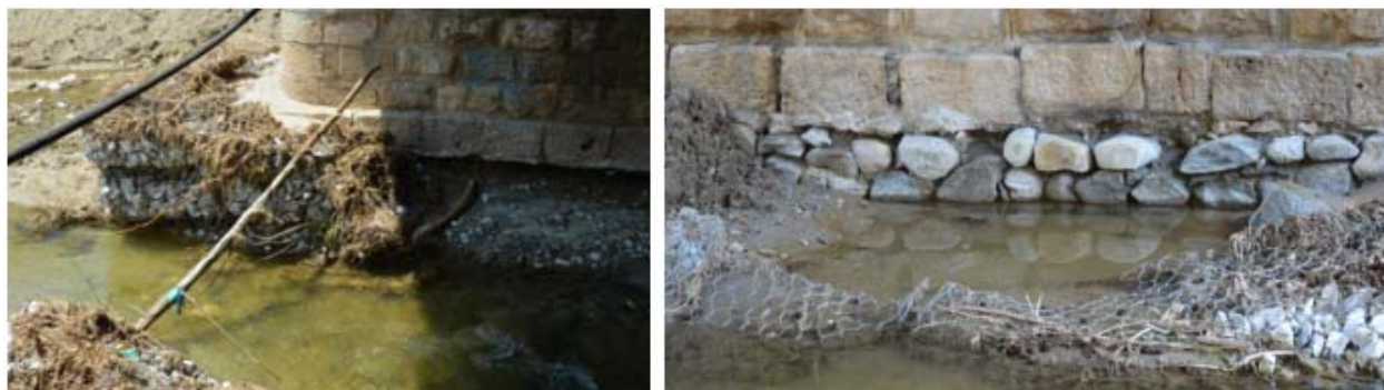
Σχήμα 4.4: Φωτογραφίες έργων υδραυλικής προστασίας μεσοβάθρων(αυτοψία μετά από πλημμύρα 21-6-2020) .
