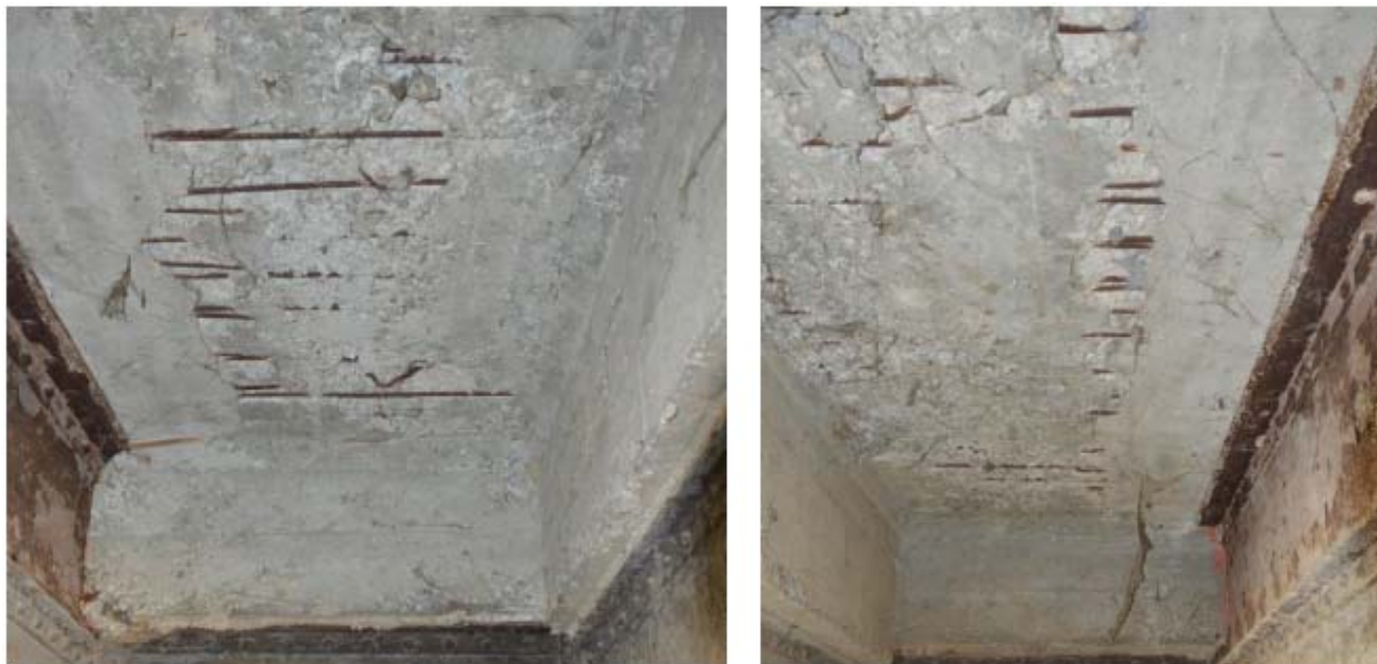
Σχήμα 4.6: Φωτογραφίες πλάκας καταστρώματος (αυτοψία μετά από πλημμύρα 21-6-2020).
