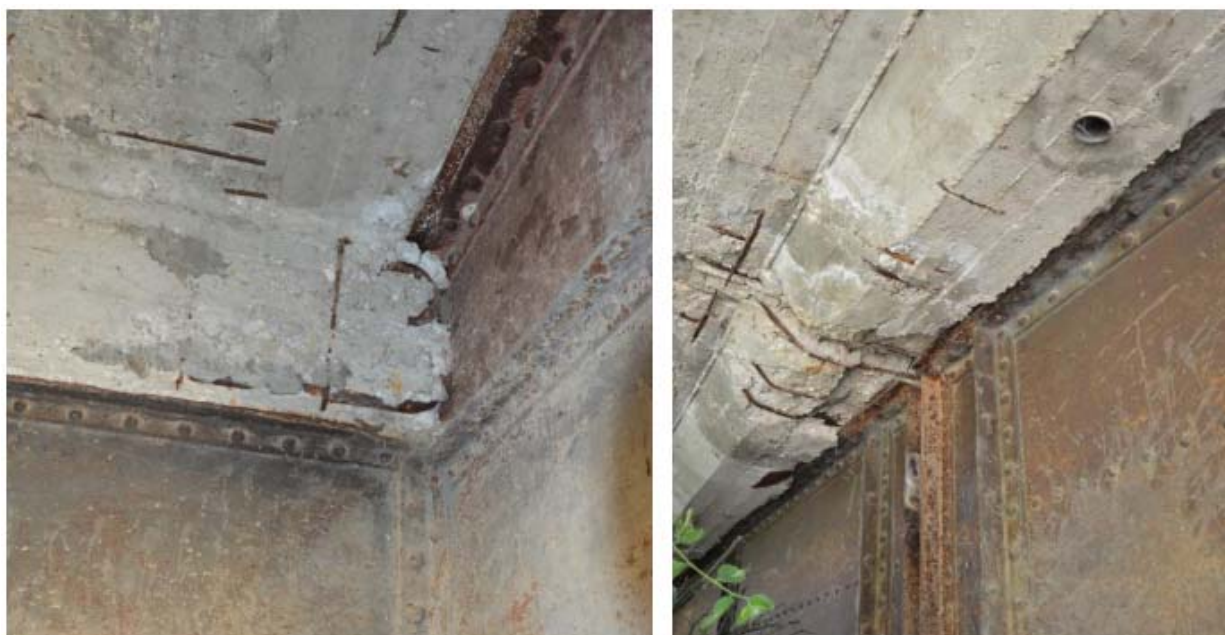
Σχήμα 4.7: Φωτογραφίες προβόλων γέφυρας (αυτοψία μετά από πλημμύρα 21-6-2020).
