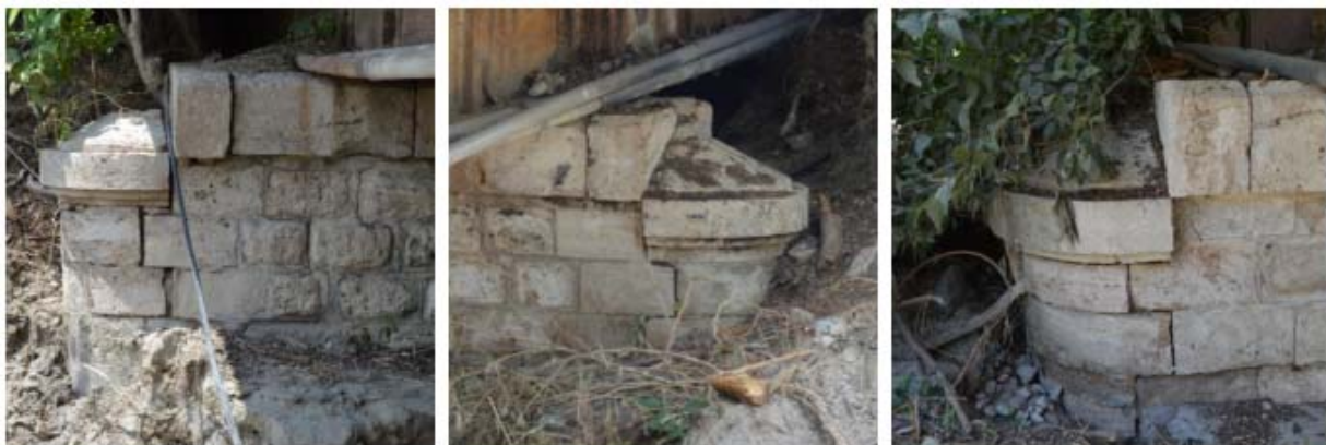
Σχήμα 4.3: Φωτογραφίες μεσόβαθρων M1 και M3 (αυτοψία μετά από πλημμύρα 21-6-2020).
