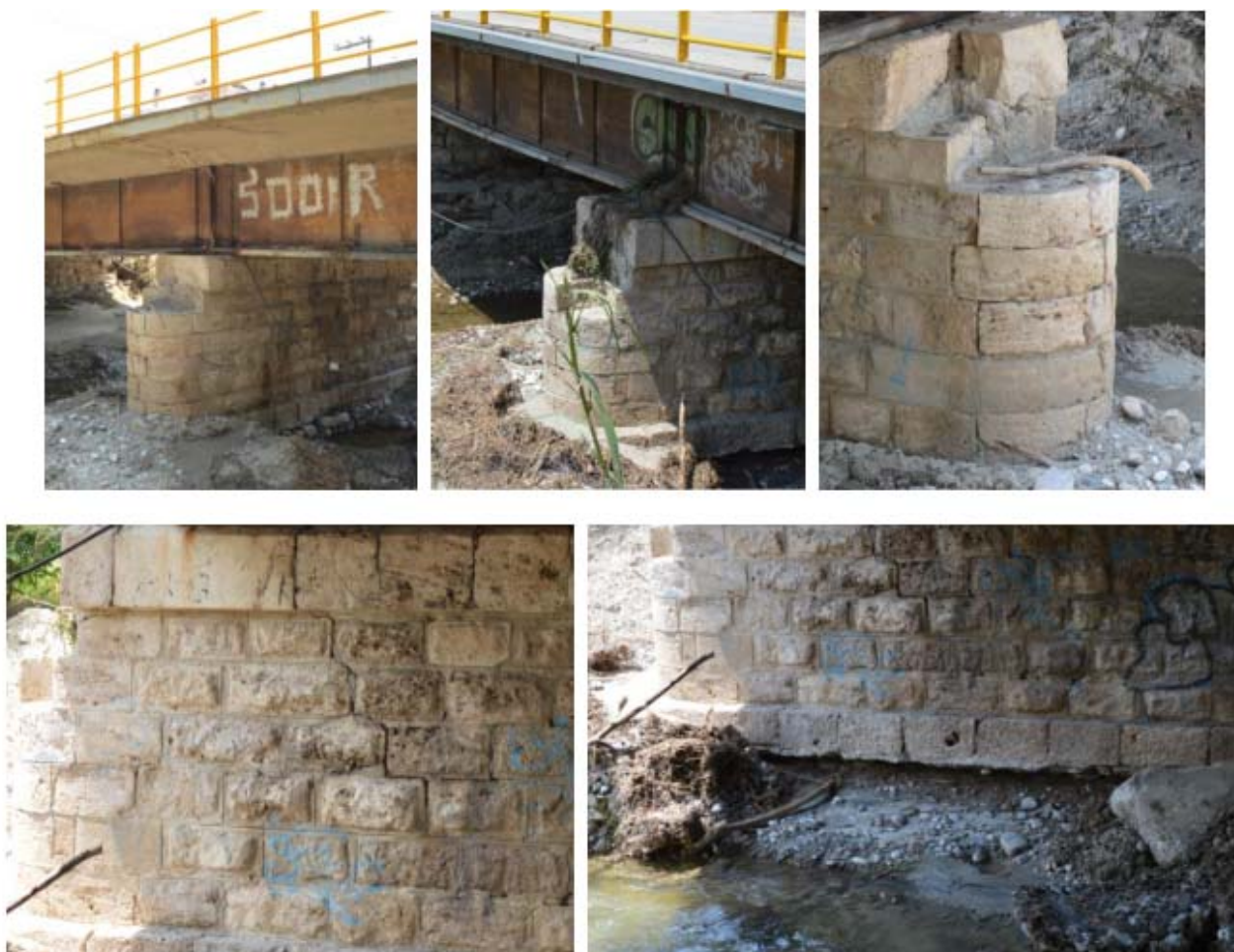
Σχήμα 4.1: Φωτογραφίες μεσόβαθρου M2 (αυτοψία μετά από πλημμύρα 21-6-2020).
