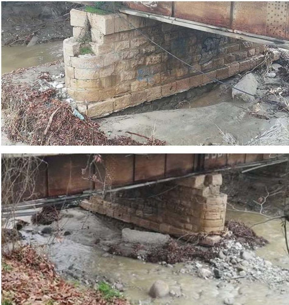
Σχήμα 4.2: Φωτογραφίες υποσκαφής μεσόβαθρου M2 (αυτοψία μετά από πλημμύρα 4-1-2021).
