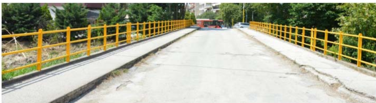
Σχήμα 4.8: Φωτογραφίες καταστρώματος γέφυρας (αυτοψία μετά από πλημμύρα 21-6-2020).
