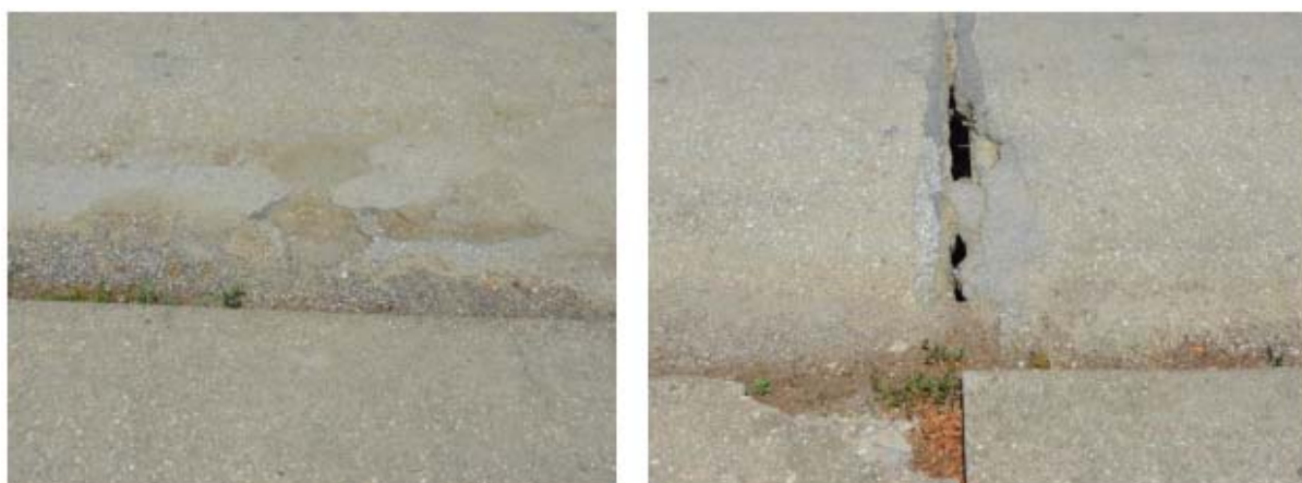
Σχήμα 4.9: Φωτογραφίες αρμών καταστρώματος γέφυρας (αυτοψία μετά από πλημμύρα 21-6-2020).
